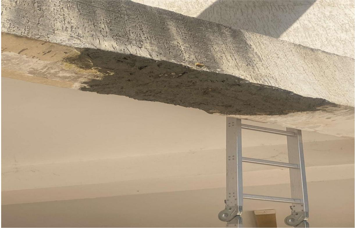
*Photo II. 9: Lisser le mortier pour obtenir une finition uniforme.*
