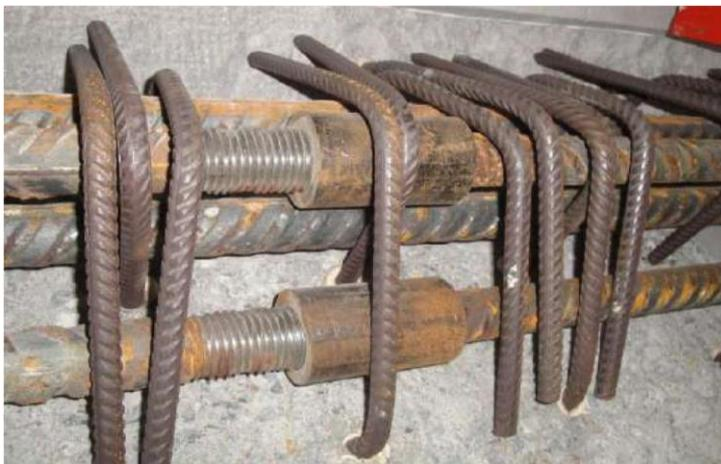
*Figure.III.26: Renforcement avec ajout d'armatures de précontraint*
