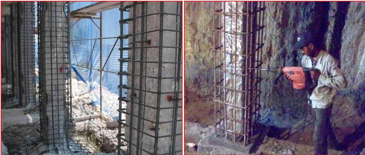
Figure.III. 28: mise en place des armatures de renforcement avec augmentation de la rugosité du pot
