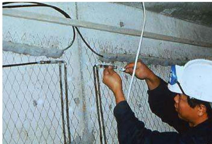
Figure.III.9: Mise en place du treillis anodique
