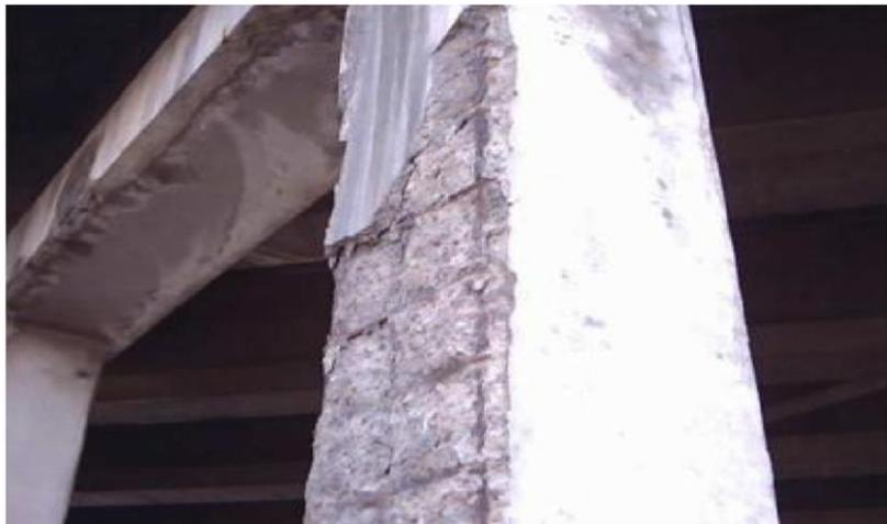
*Figure.I. 8: Décollement du parement du pilier et fissuration du chevêtre*
