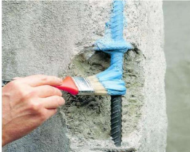
*Figure.III.18 : Inhibiteurs de corrosion*
