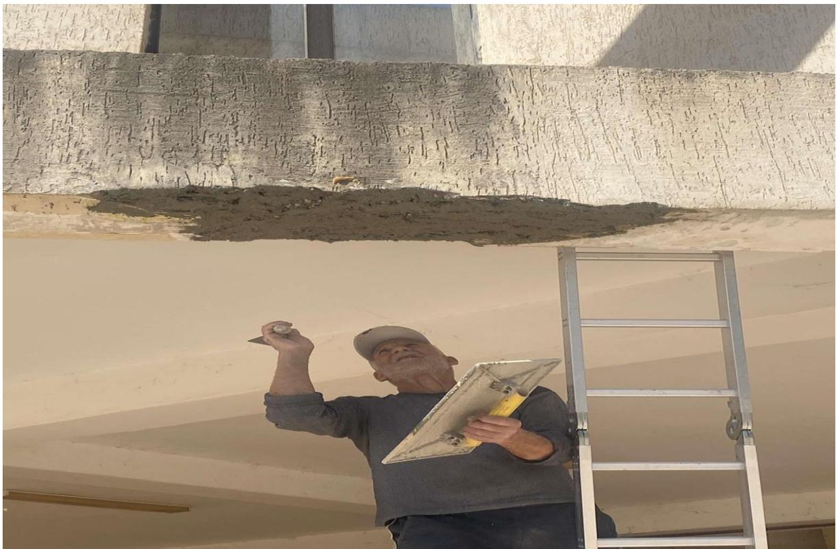
*Photo II. 10 : Laisser sécher le mortier avant de procéder à la finition et appliquer une protection contre la corrosion si nécessaire.*
