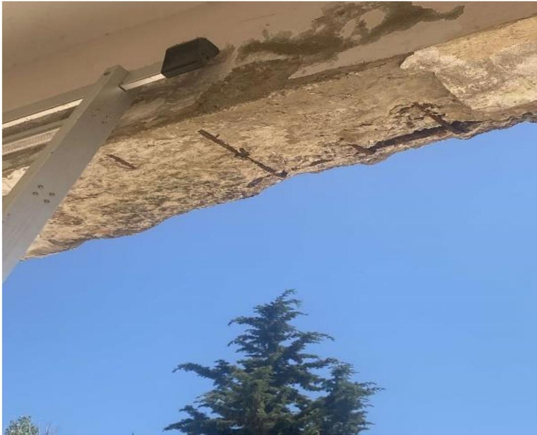
*Photo II. 6: la zone critiquée par la corrosion*
