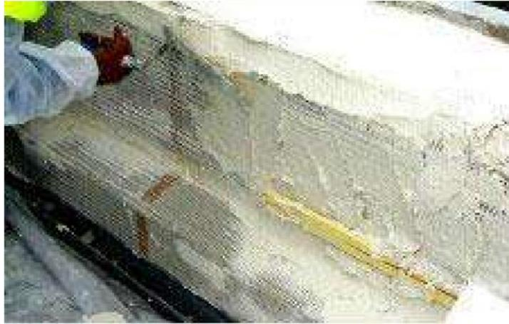
*Figure.III.15: Enrobage d'une anode pour traitement de ré-alkalinisation à l'aide d'anode galvanique.*
