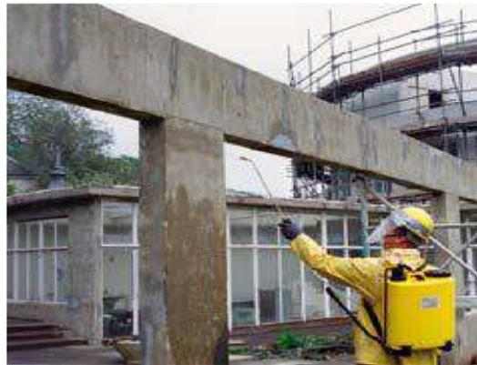
*Figure.III.17: Application d'inhibiteurs de corrosion dans ou sur le béton*
