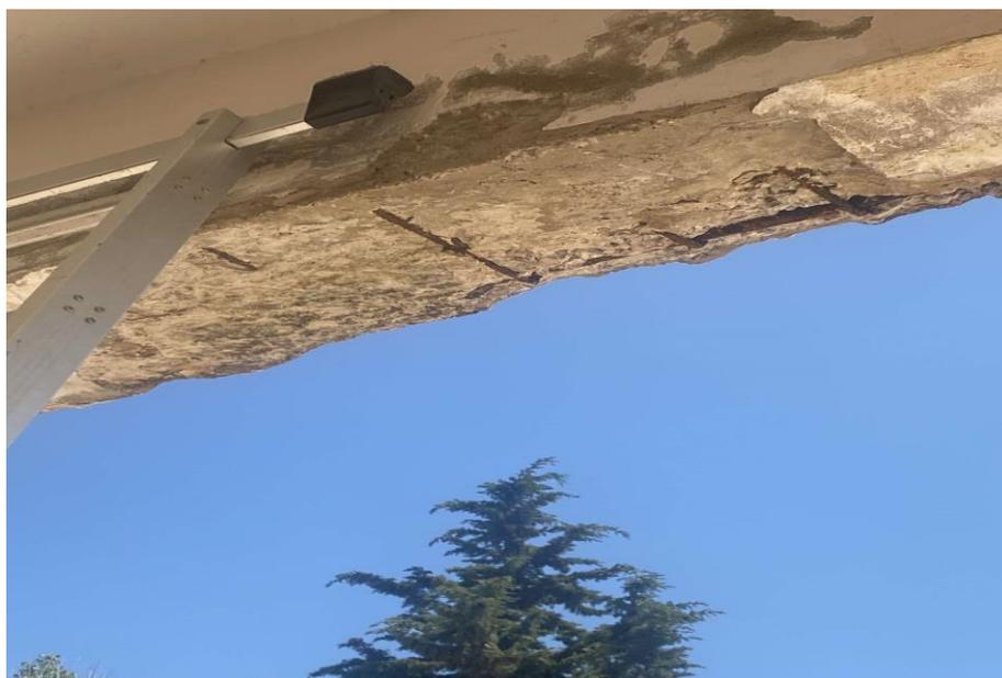
*Photo II.3: Dégradation avancée du béton armé*
