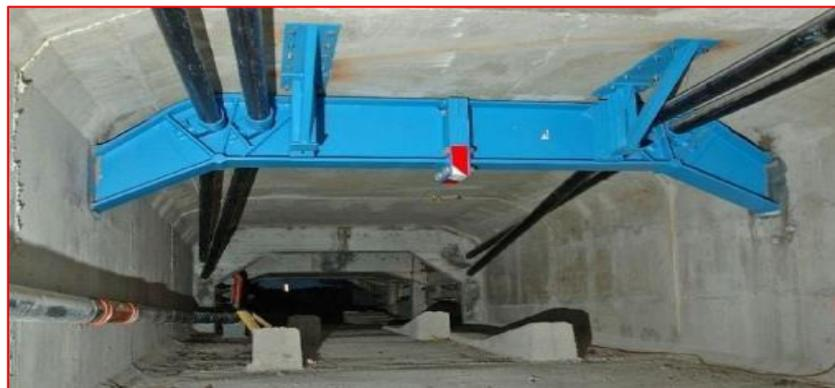
*Figure.II. 33 : technique de précontrainte additionnelle*
