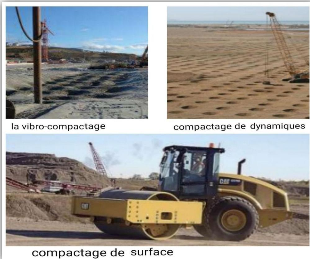
**Fig.VII.3 :** Les types de compactage.
