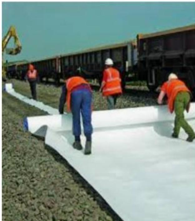
**Fig.VII.5:** Technique de la stabilisation par géotextiles.
