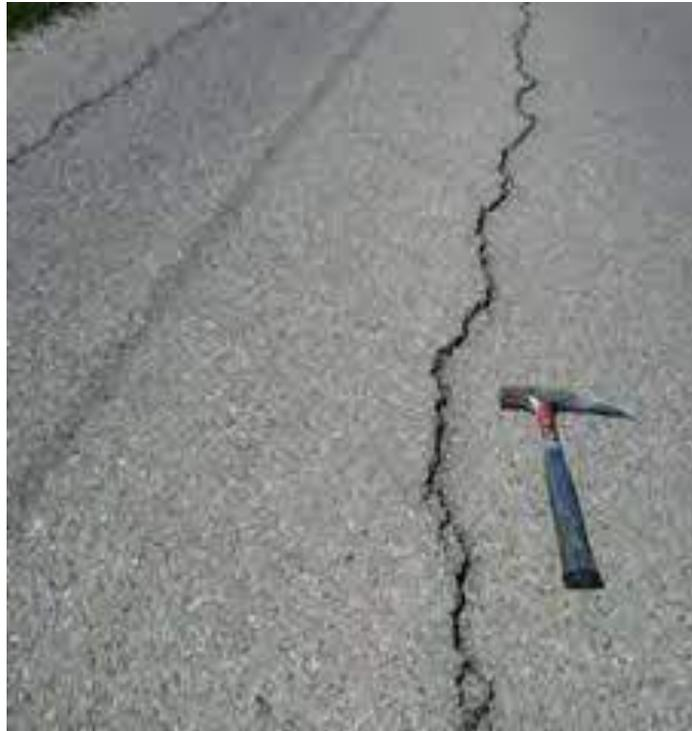
**Figure VII.2:** Fissuration de la chaussée.
