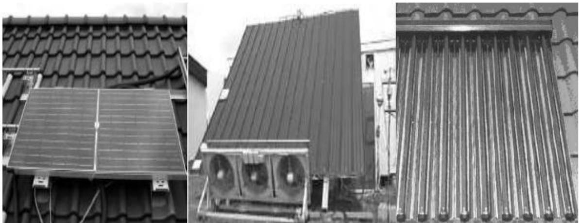
Il existe ainsi les capteurs solaires plans vitrés convenant mieux à des applications à température modérée (comprises entre 30 et 70 °C) tels que le chauffage de l'eau sanitaire, des piscines d'intérieur et le chauffage des bâtiments. Ils se distinguent des capteurs solaires plans sans vitrage qui conviennent à des applications à basse température (inférieure à 30 °C), telles que le chauffage des piscines d'extérieur. Nous pouvons également citer les capteurs
