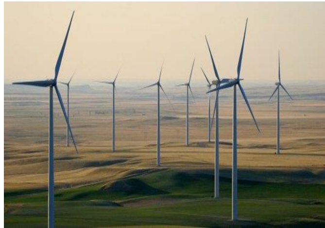
Figure (I.1) : une central éolienne
