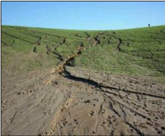
Figure.7 : Erosion en rigole.
