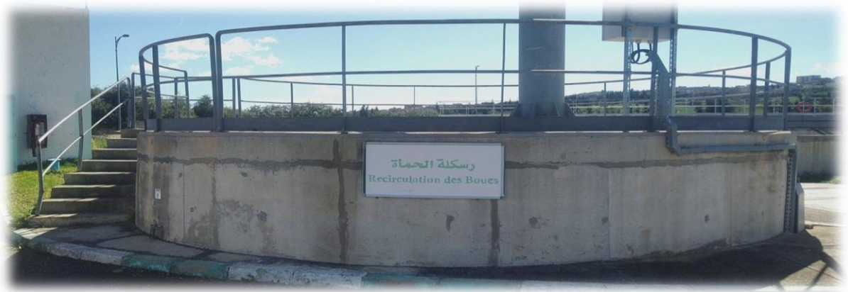
Figure (33) : Recirculation des boues.
