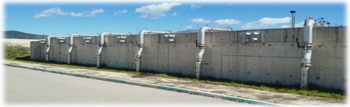
Figure (30) : Système d'aération.
