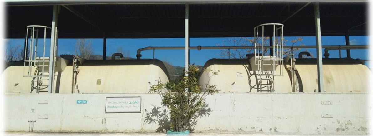
Figure (41) : Poste \text{FeCl}_3 .
