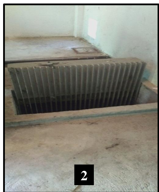
Figure (21) : Dégrilleur grossier (1 : manuelle, 2 : automatique).
