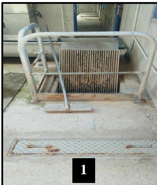
Figure (22) : Dégrilleur fin ( 1 : manuelle , 2 : automatique )
