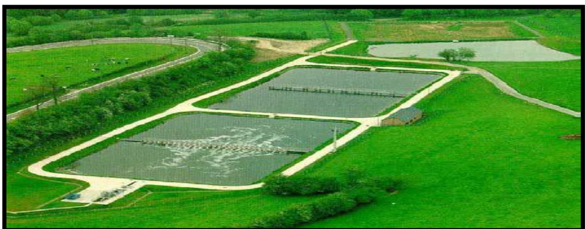
Figure(11) : Lagunage aéré [35].
