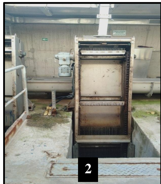
Figure (22) : Dégrilleur fin ( 1 : manuelle , 2 : automatique )
