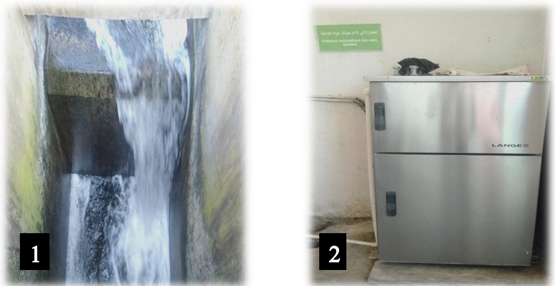
Figure (44) : Prélèvement à la sortie (1 : point de prélèvement après décanteur ; 2 : préleveur automatique des eaux épurée).
