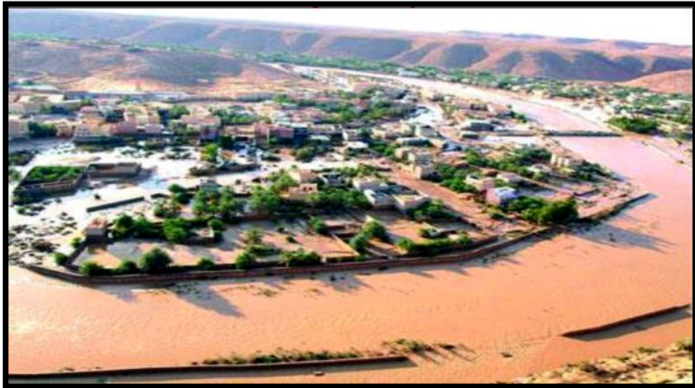
Figure I-1 : Inondation dans la ville de Ghardaïa, Octobre 2008 [3].
