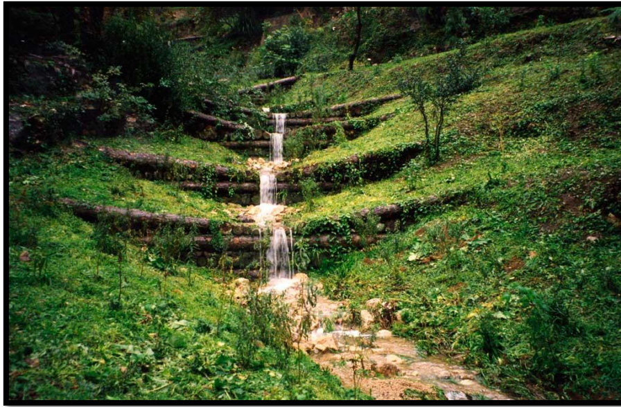
Figure I-17 : Correction torrentielle, ville de Grasse [k].
