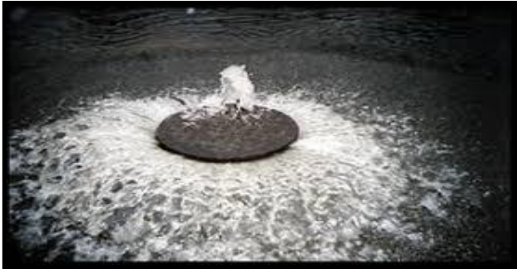
Figure I-7 : Inondation par débordement de réseau d'assainissement [f].
