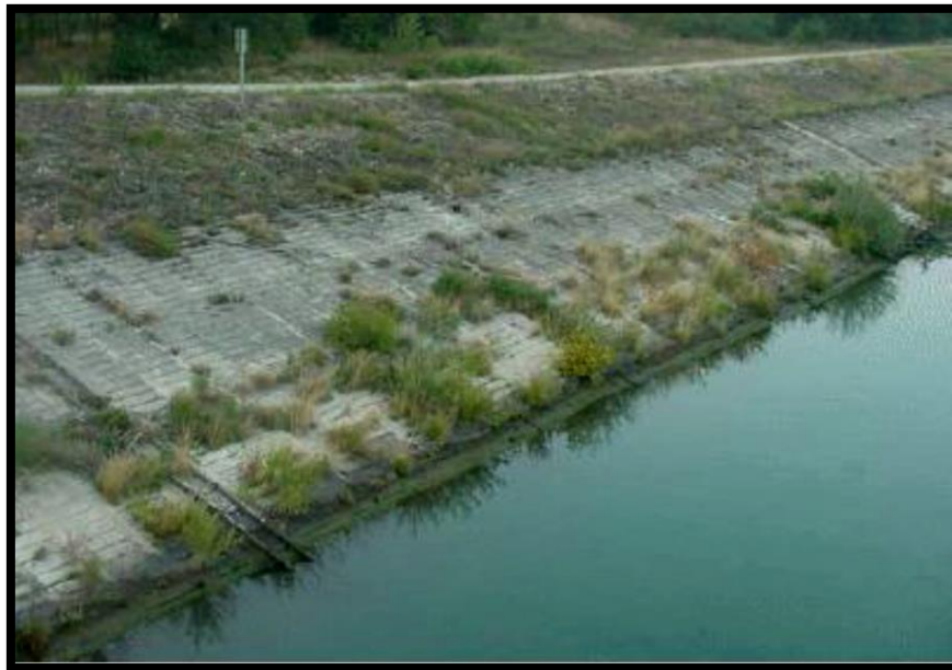
Figure I-14 : Digue de navigation du Rhône en charge en permanence [5].
