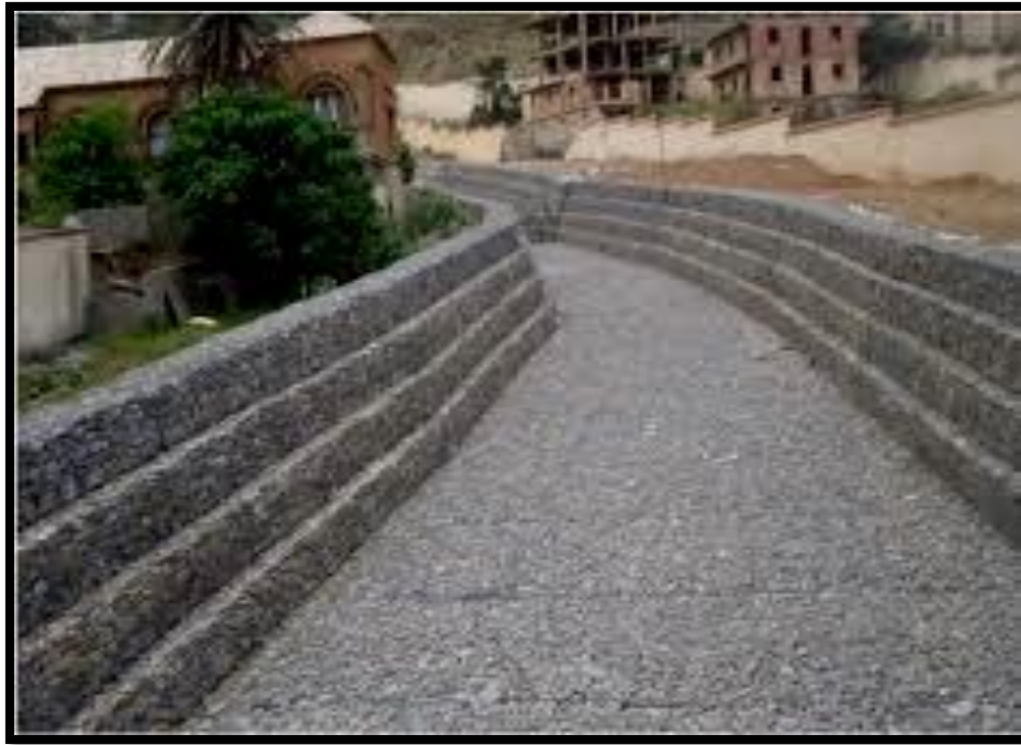
Figure I-13 : Réalisation des canaux dans un oued dans la wilaya d'Alger [j].
