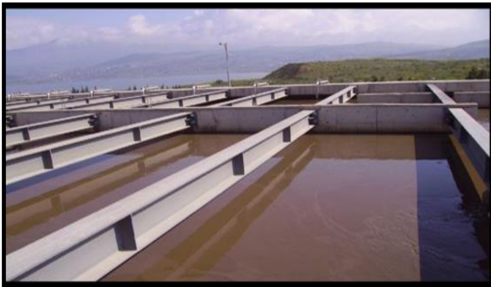
Figure 20 : points des prélèvements au niveau du bassin biologique à la STEP de Sidi Merouane
