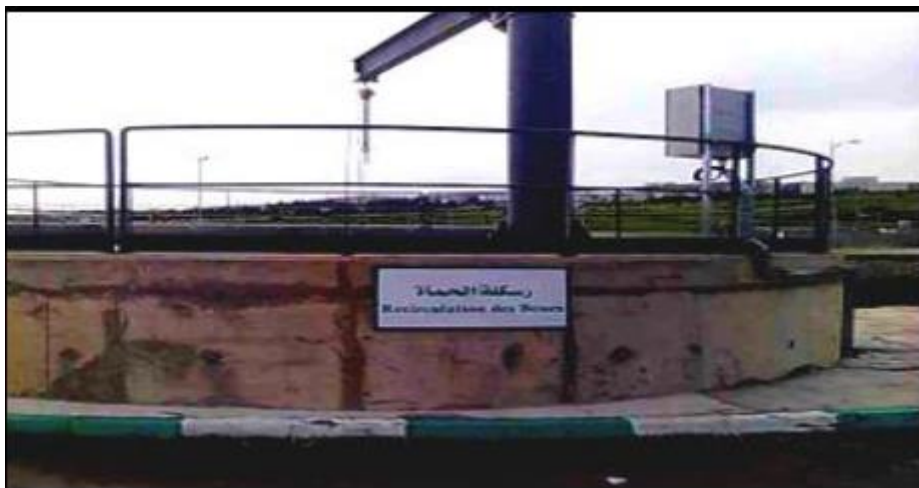
Figure 15 : Recirculation des boues
