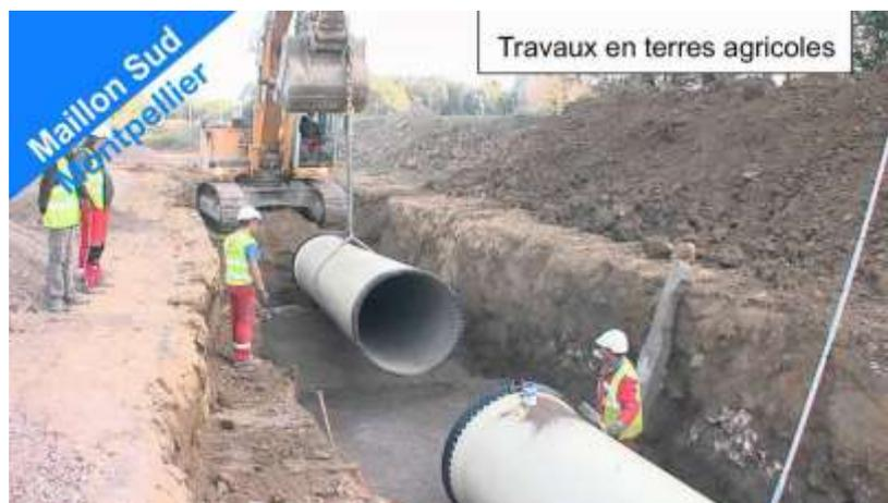
**Photo 6 :** Pose de la canalisation.
