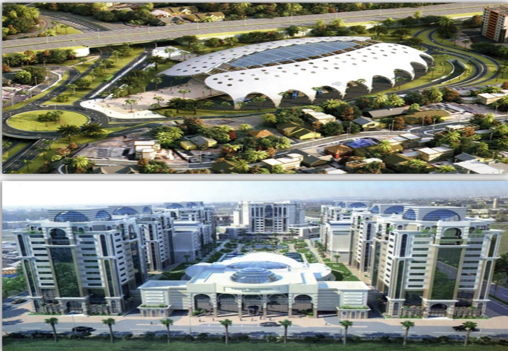
Figure 1.1: Deux projets prioritaires en cours de réalisation (PDAU d'Alger). source : [6].
