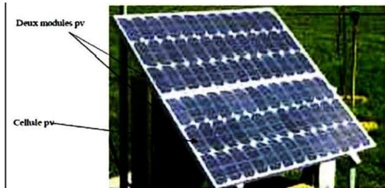
Figure I-21 : Exemple d'un panneau solaire.
