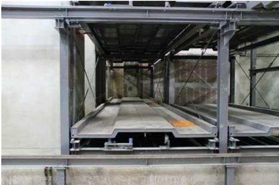
**Figure II.9 : Stationnement Horizontal de Circulation [10].**
