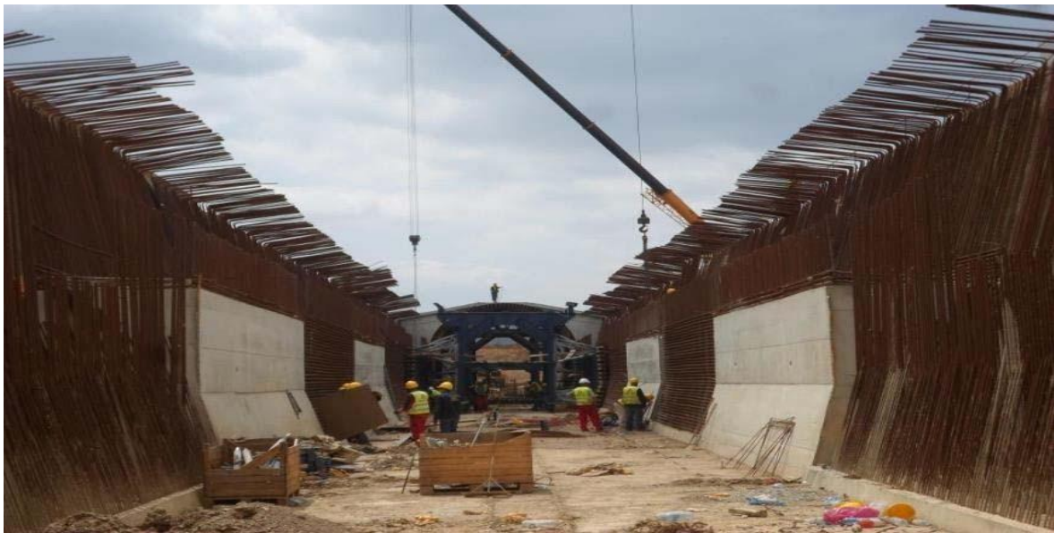
Figure III.5 dérivation provisoire en cours de construction [20]
