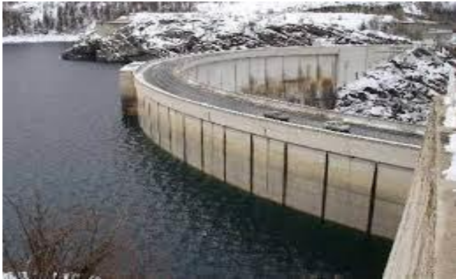
Figure I.4 Barrage-voûte de Tignes [6].
