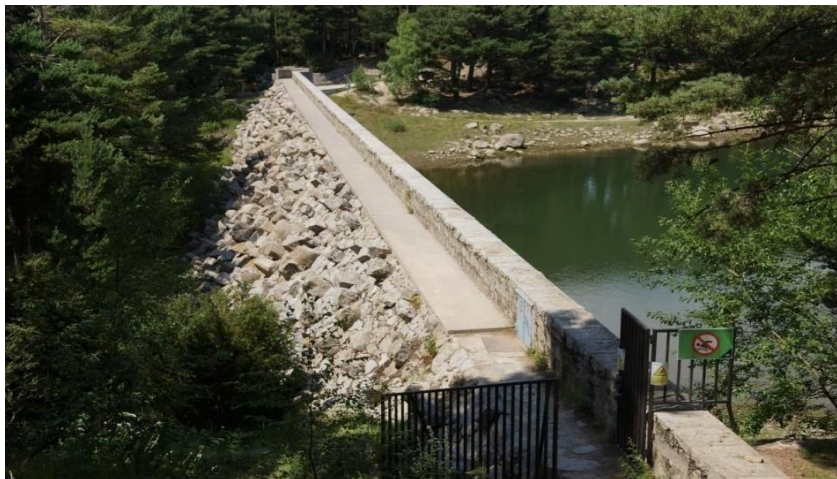
Figure I.7 Barrage en enrochement [11].
