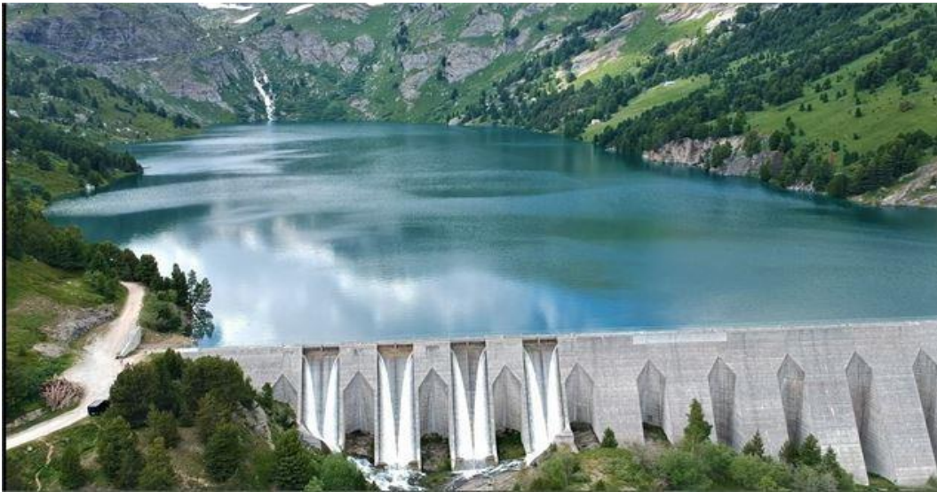
Figure I.5 Barrage poids à contreforts de Plan d'Amont [11].
