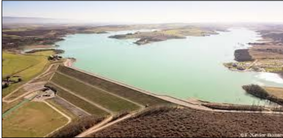
Figure I.8 Barrage en terre [3].
