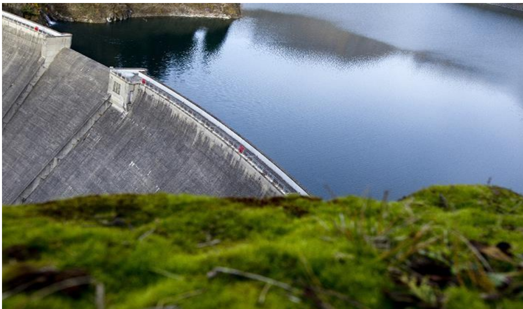
Figure I.3 Barrage de Sarrans, France [6].
