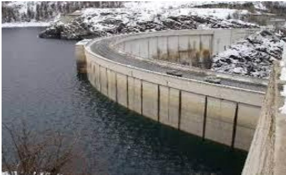
Figure I.3 Barrage-voûte de Tignes [6].
