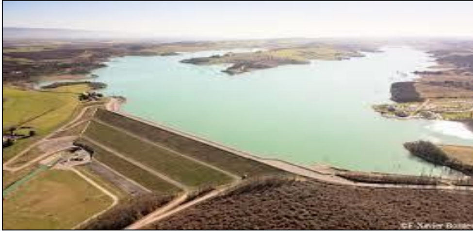
Figure I.7 Barrage en terre [3].
