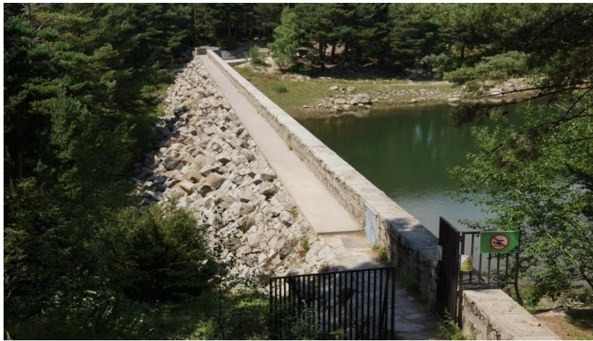
FigureI.6 Barrage en enrochement [11].
