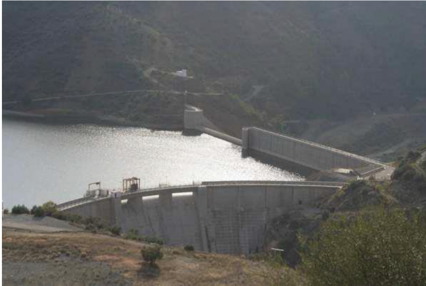
Figure I.13 : Barrage-voûte (Barrage Tichy Haf Bejaia -Algérie).
