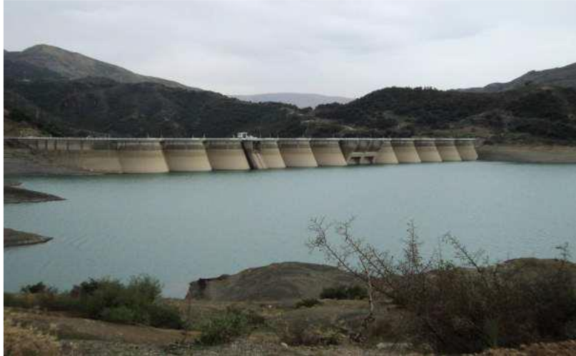
Figure I.11 : Barrage à contrefort (barrage Erra Guéné Jijel-Algérie).
