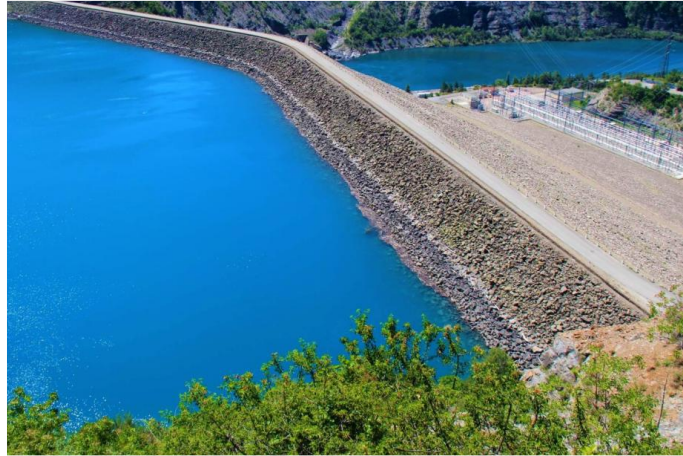
Figure I.1. Photographie d'un barrage souple.
