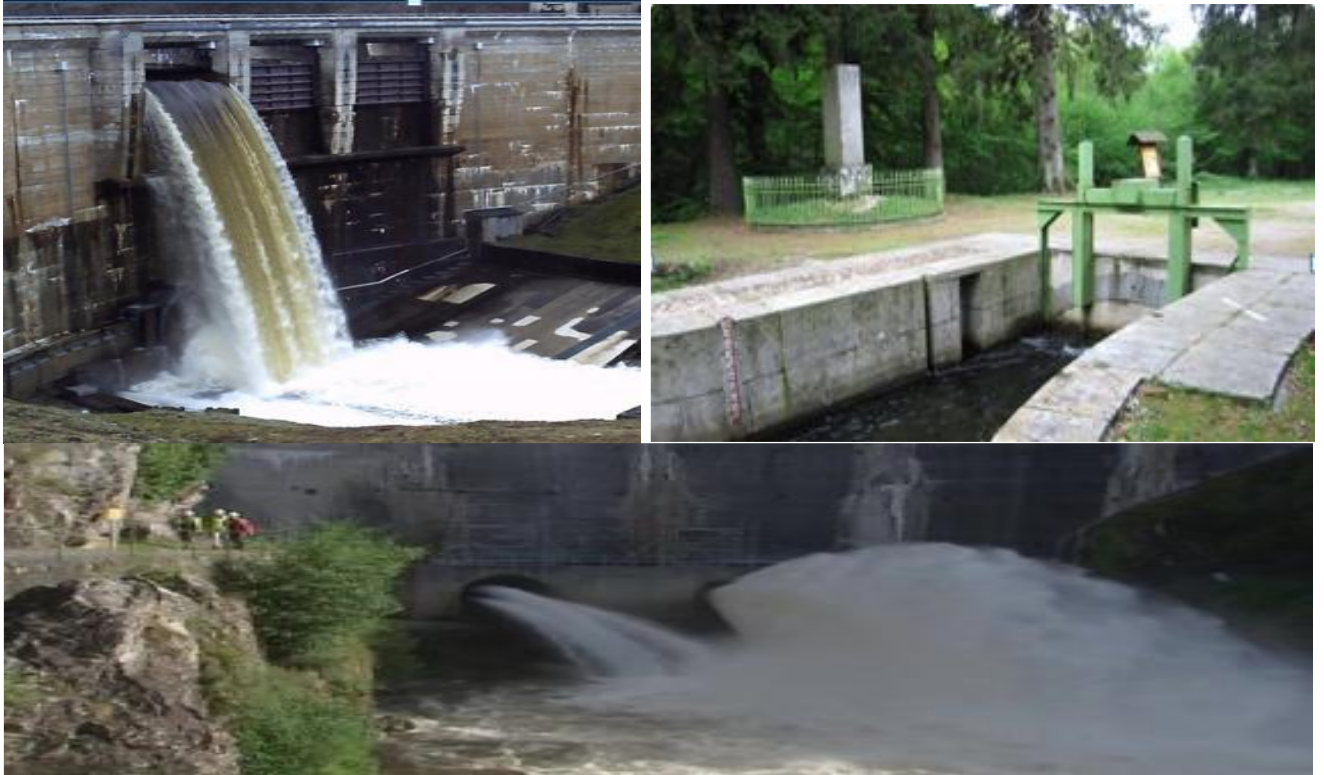
Figure I.14 : Photographie des équipements de sécurité. [24]
