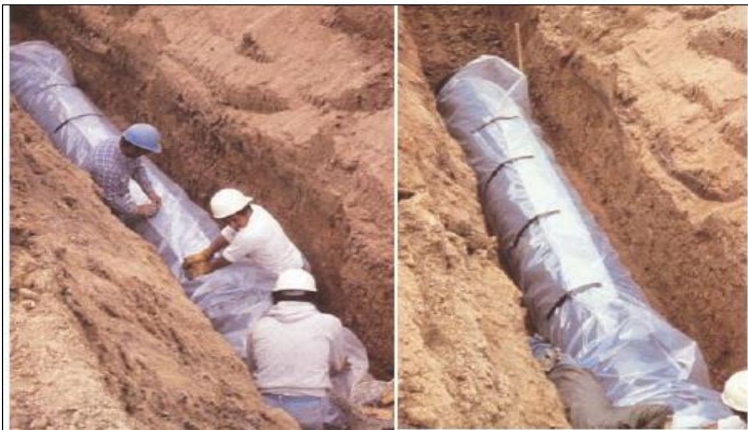
Figure VI- 2 : Protection contre la corrosion extérieure avec revêtement en polyéthylène.
