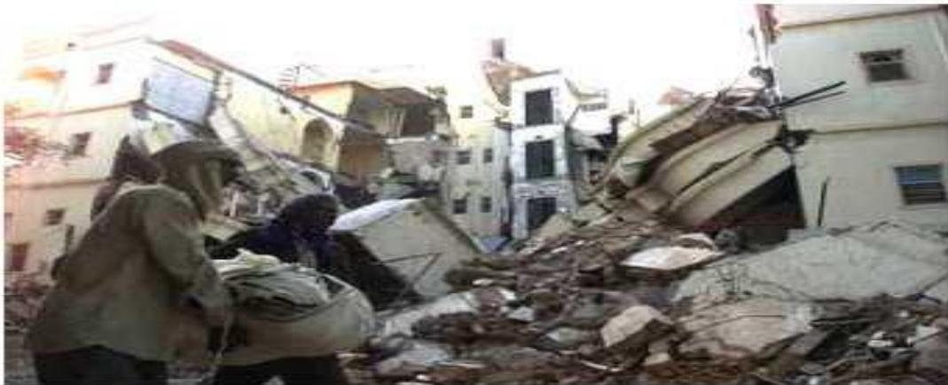
**Figure I.4.** Désagrégation complète de bétons de mauvaise qualité (Séisme de Bhuj, Inde, 2001).
