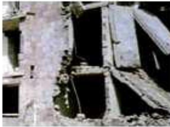
**Figure I.11.** Ruine de planchers par perte d'appui (séisme de Spitak, Arménie 1988).
