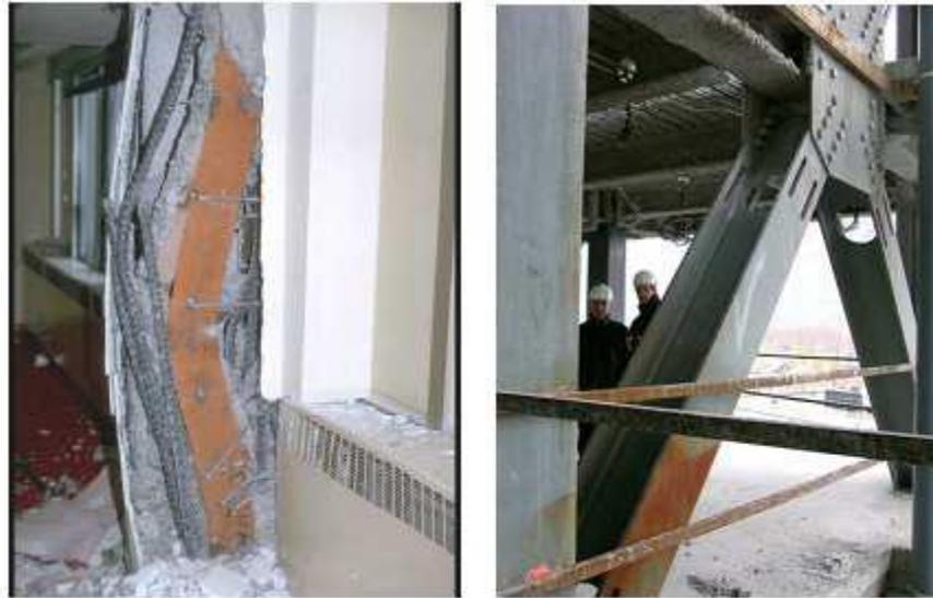
**Figure I.17.** Flambement inapproprié d'un poteau d'acier enrobé de BA (Séisme d'Anchorage, 1964).
