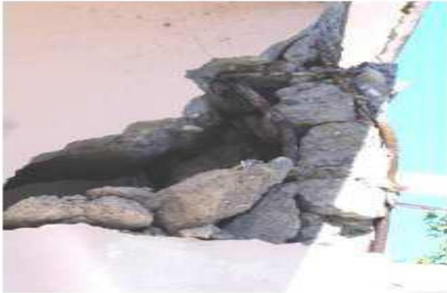
**Figure I.7.** Poteau d'angle (Séisme de boumerdes).
