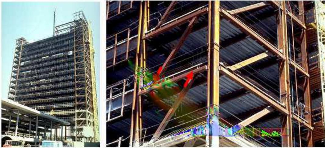
**Figure I.29.** Les palées de stabilité excentrées.
