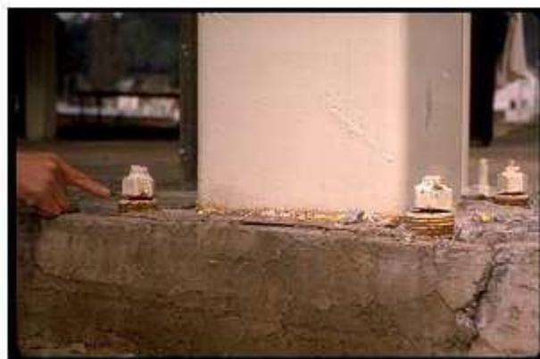
**Figure I.30.** Plastification des tiges filetées (Séisme du Chili, 1960).
