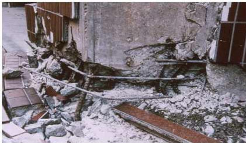
**Figure I.6.** Rotule plastique en pied de poteau.
