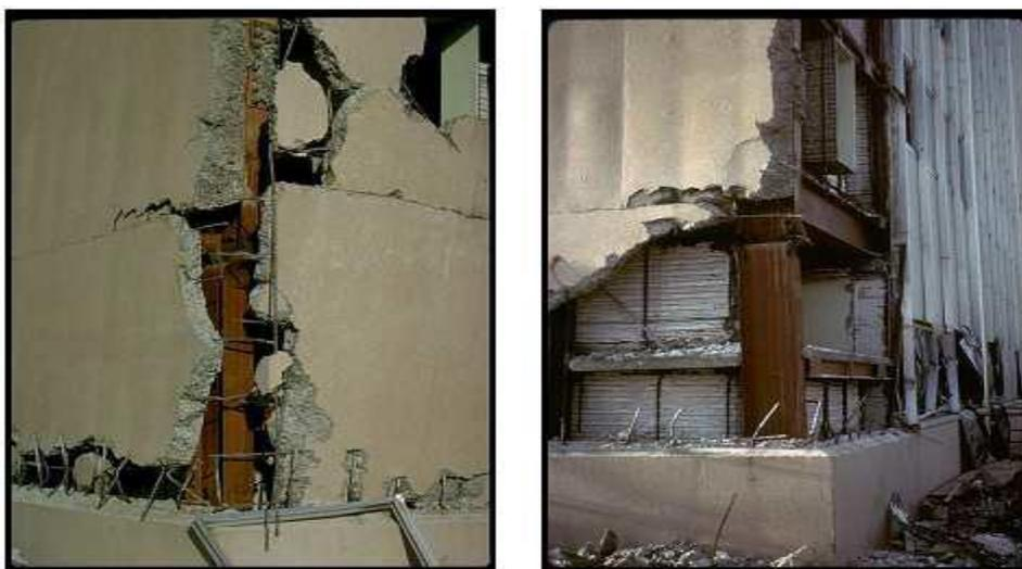
**Figure I.36.** La façade rideau rigide en béton armé n'a pas supporté les déformations de la structure d'acier. (Séisme d'Anchorage 1964).
