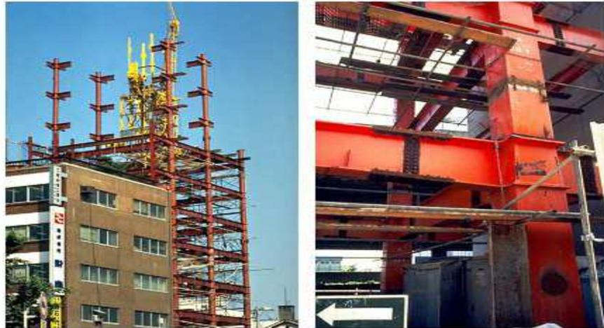
**Figure I.25.** Les poteaux et nœuds d'ossature, sont produits en usine.
