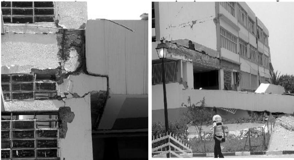
**Figure II.3.** Effondrement de structure suite à une erreur de conception (séisme de Boumerdès).
