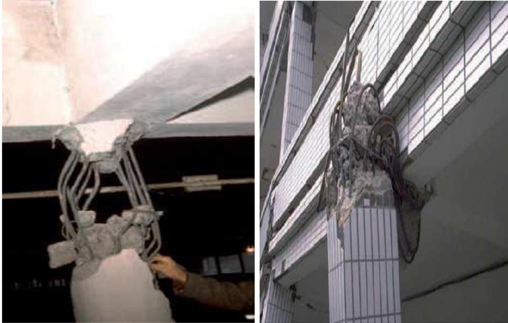
**Figure I.8.** Éclatement de zones critiques, extrémités des poteaux et poutres.
