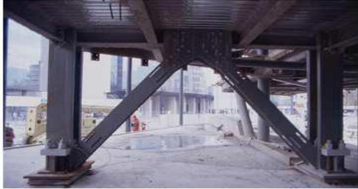
**Figure I.28.** Plastification d'une barre de contreventement en V suite à un séisme
