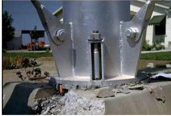
**Figure I.31.** Dommages sur le massif de béton.
