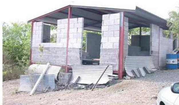
**Figure I.33.** A gauche : Armature des maçonneries de remplissage. A droite : Remplissage en maçonnerie des structures métalliques.
