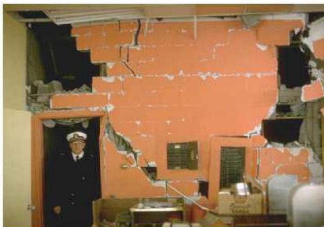
**Figure I.34.** A gauche (séisme de Tokyo, 1923), dommages aux maçonneries extérieures. A droite (séisme d'Anchorage, 1964), dommages aux maçonneries intérieures.
