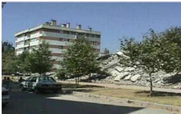
**Figure I.9.** Comportement de deux immeubles voisins face aux secousses sismiques.
