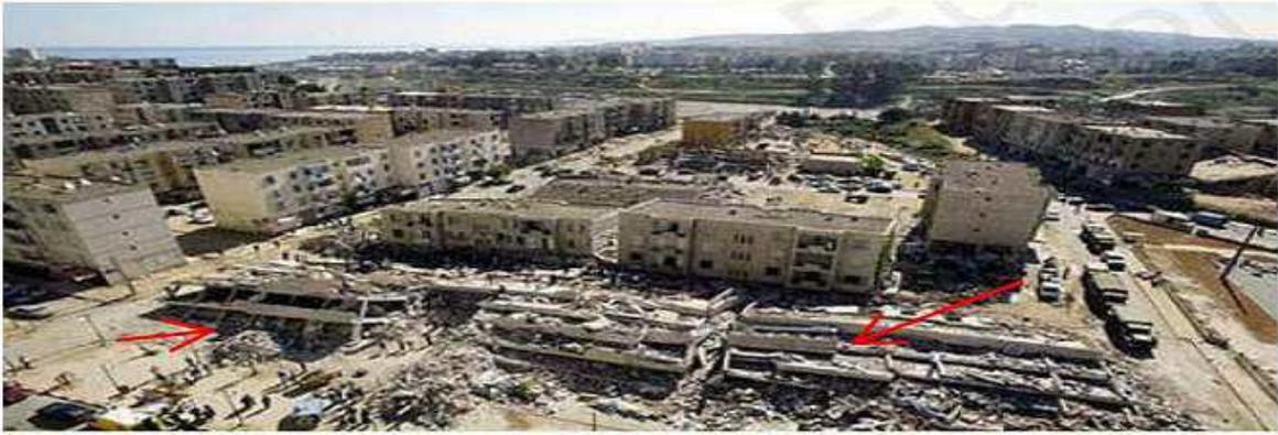
**Figure I.3.** Effondrement total d'une structure à ossature de béton armé manquant ductilité (Séisme de de boumerdas 2003).
