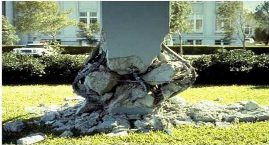
**Figure I.5.** Rupture fragile d'un pied de poteau.
