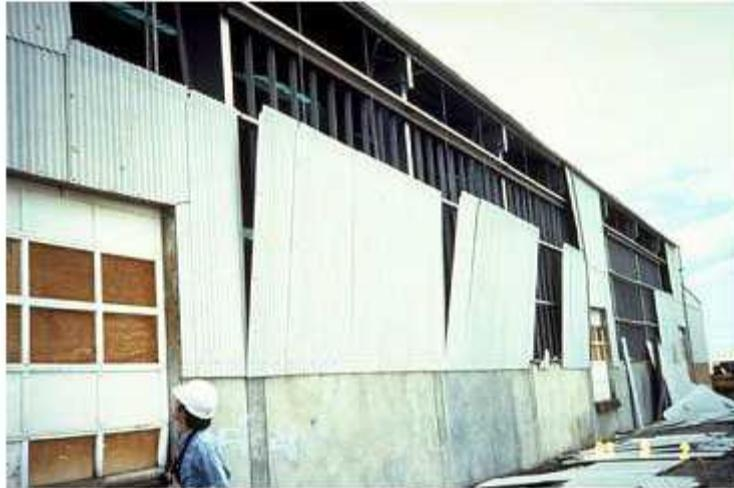
**Figure I.35.** (Séisme de Coalinga, 1983) chute des bardages mal fixés.
