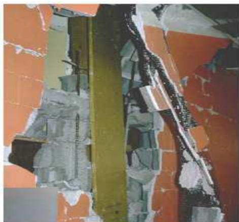
**Figure I.16.** Destruction de parois en maçonnerie armée. Séisme d'Anchorage (1964).
