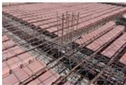
Figure I.7. Dalle à corps creux.
