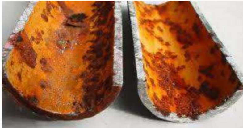
Figure III.2 : Corrosion interne du tube de la canalisation.
