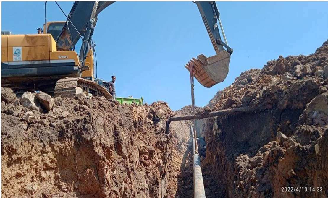
Figure IV.9 : Croisement gazoduc avec conduite d'eau et d'une piste forestière (Pk : 7+155.07).
