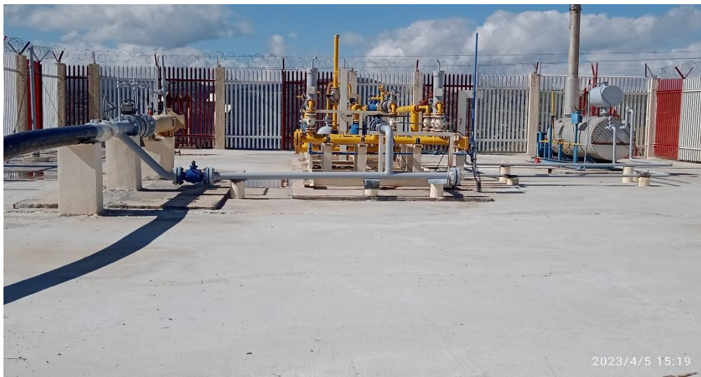
Figure I.10: Poste de détente DP Tassadane Haddada ; Capacité : 5000 Nm 3 /h (W. Mila).
