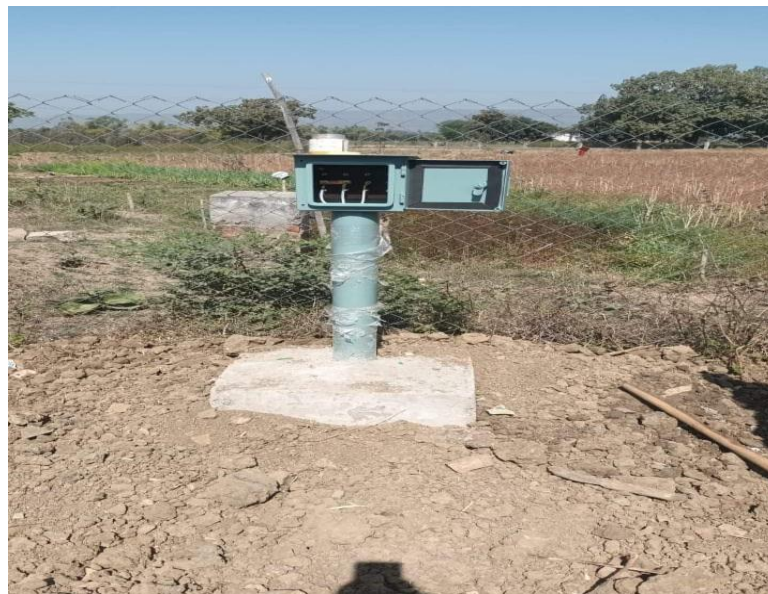
Figure II.8 : Prises de potentiel et courant.
