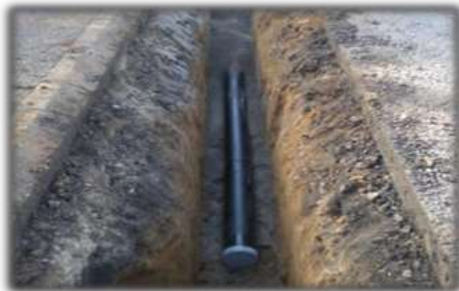
Figure 4 : Pose des canalisations
