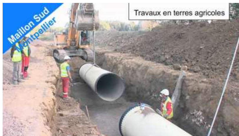
Photo 6 : Pose de la canalisation.
