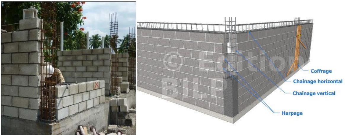
Fig. I.3 : Maçonnerie chaînée.[3]
