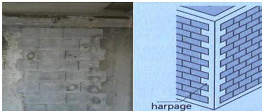
Fig. I.4 : La maçonnerie chaînée en harpage.[3]
