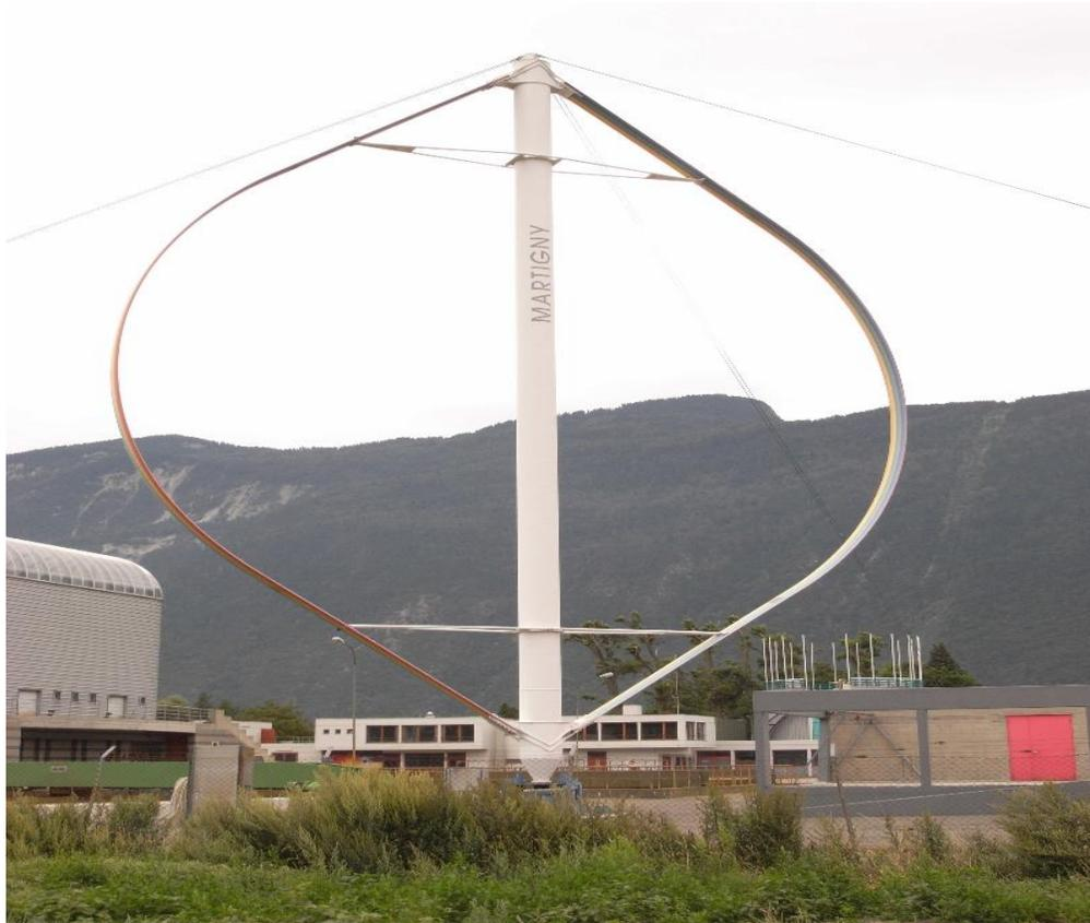
**Figure (II.15) :** Eoliennes à axe vertical (Darrieus) [53]
