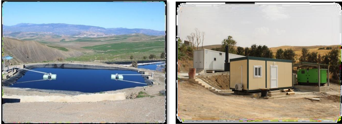
Figure 9 : La station du traitement de lixiviat CET Mila(Cliché perssonel, Mai 2022).
