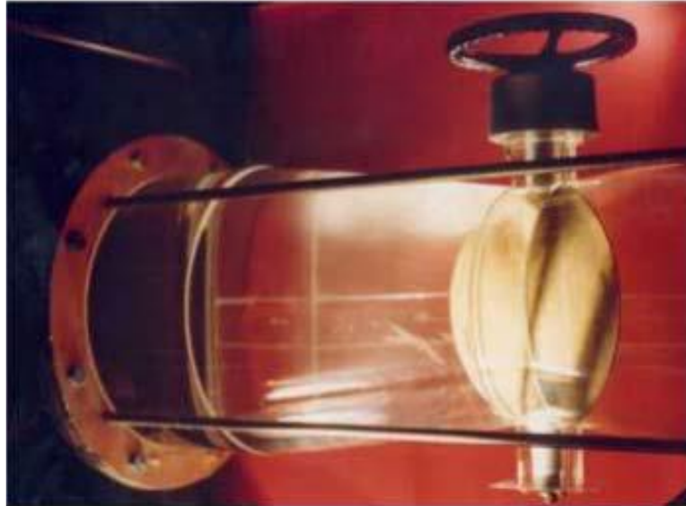
Figure II.7 : Cavitation de mélange en aval d'une vanne papillon.
