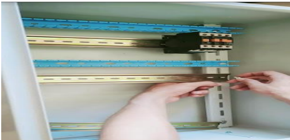
Figure 3.19 : L'installation des composants électriques.
