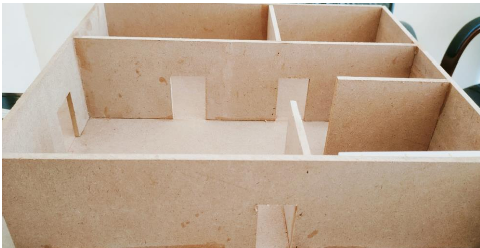
Figure 3.23 : La façade de la maison après avoir placé les murs.
