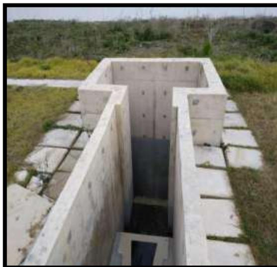
**Figure 24** : l'ouvrage de dégazeur (STEP, Ain Baida Harriche).
