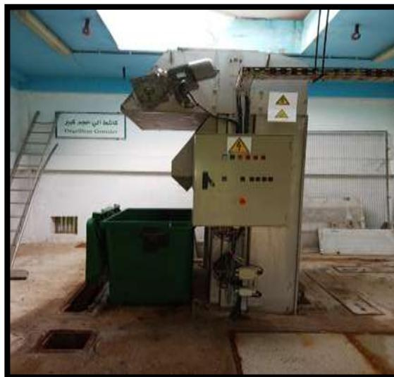
**Figure 10** : dégrilleur mécanique
