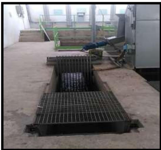
**Figure 07 :** dégrilleur manuelle
