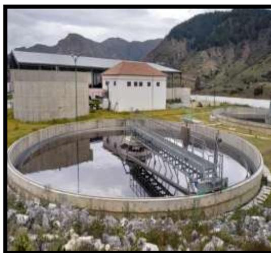
**Figure 26** : Clarificateur (STEP, Ain Baida Harriche).
