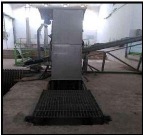
**Figure 09** : dégrilleur mécanique
