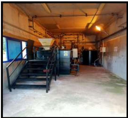
**Figure31** : déshydratation des boues par centrifugation (STEP, Sidi Merouane).
