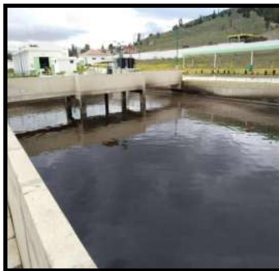
**Figure 22** : Zone aérée dans le chenal (STEP, Ain Baida Harriche).
