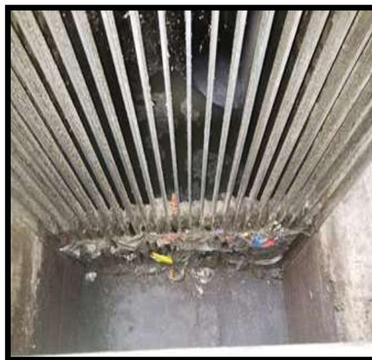
**Figure 08 :** dégrilleur manuelle
