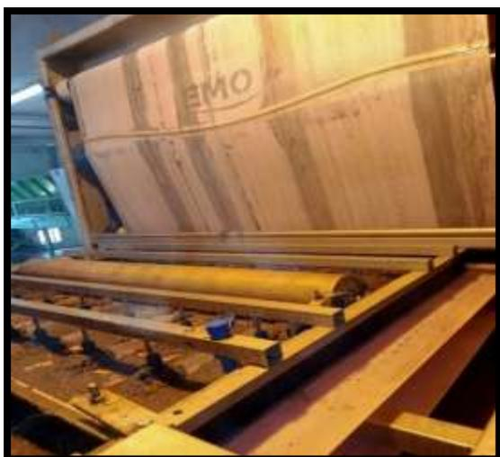
**Figure 29** : déshydratation des boues par filtration (STEP, Sidi Merouane).
