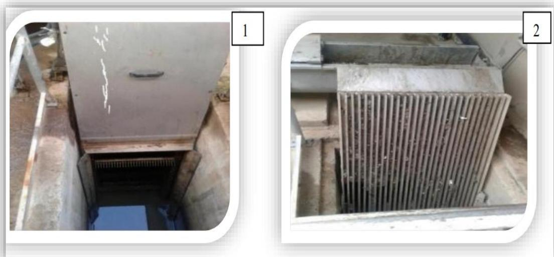
**Figure 22:** Dégrillage fin 1. Automatique, 2. Manuelle.
