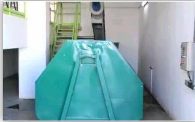
**Figure 28:** Benne à sable.
